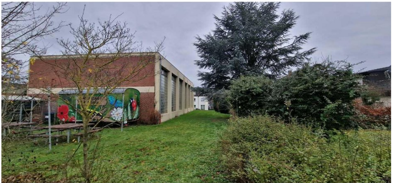
Abbildung 5: Ansicht des Turnhalle etwa aus östlicher Richtung.
