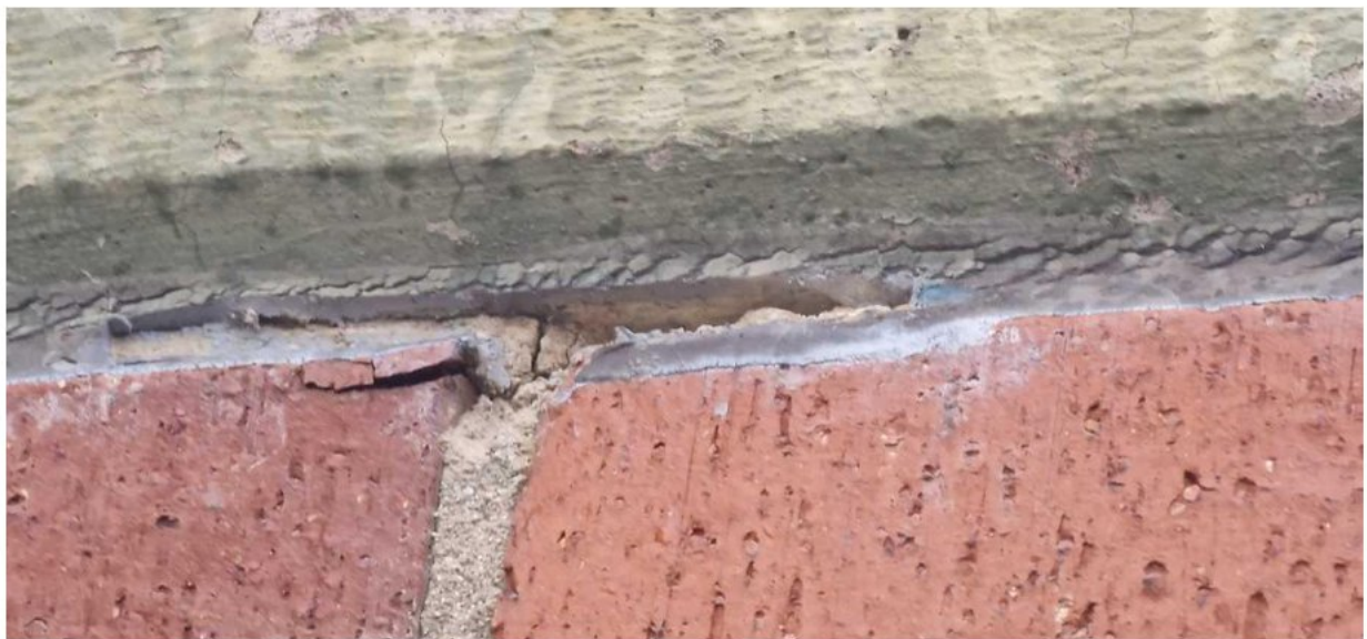
Abbildung 14: Probe A2, Fassade Fugenmasse
