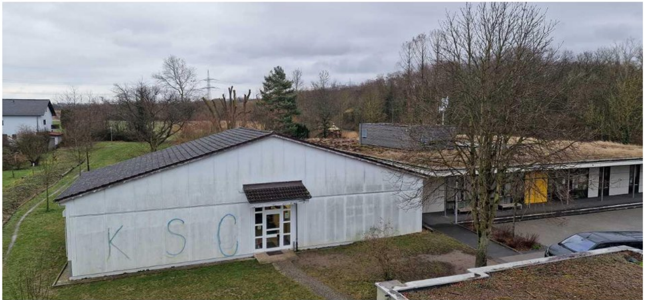
Abbildung 2: Das untersuchte Gebäude (Anbau) aus westlicher Richtung (Markierung).
