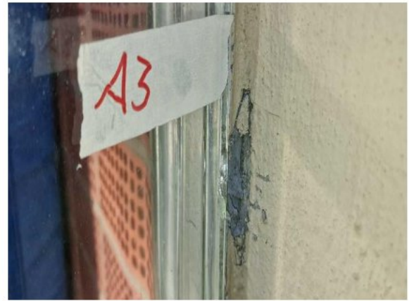
Abbildung 44: PN – Stelle A3, Fugenmasse.
