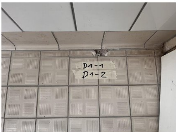
Abbildung 41: PN – Stellen D 1-1, D 1-2, Fugenmasse, Kleber.
