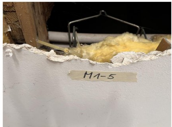
Abbildung 37: PN – Stelle M 1-5, Gipsfaserplatte.
