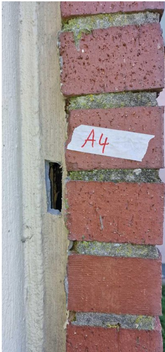
Abbildung 46: PN – Stelle A4, Fugenmasse.
