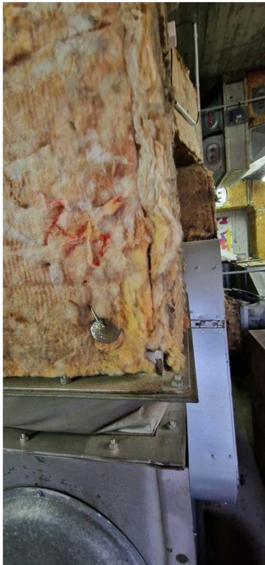
Abbildung 15: Probe H1, Heizung KMF
