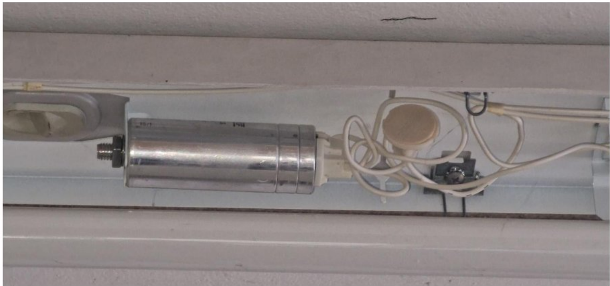
Abbildung 49: PN – Stelle M 1-6, Kondensator.
